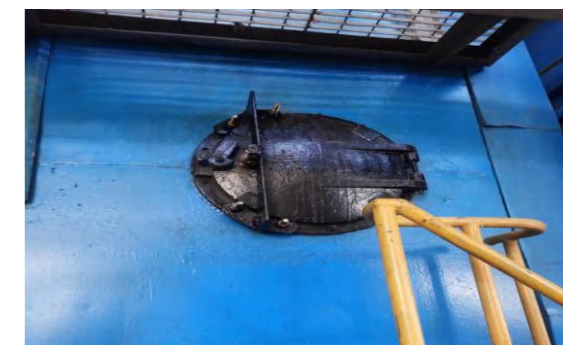
锅炉炉门改造后(螺栓式)
